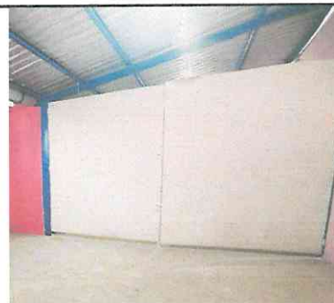
Foto 6: Sustitución de cancel de madera, por división de madera movil de 2.80 metros X 2.35 metros.
