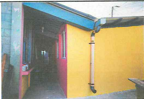
Foto 1: Muro de block con repello, cernido y pintura
