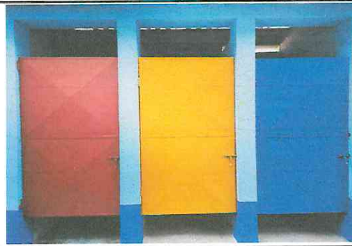
Foto 4: Mantenimiento de puertas sustitución de pasadores y pintura de interior y exterior de las puertas.
