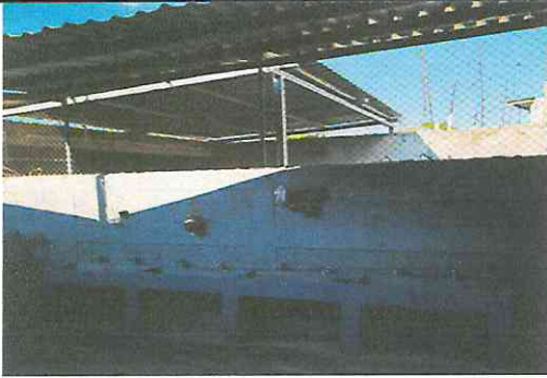
Foto 1: Lavamanos sustitución de tubería y de 8 chorros.
