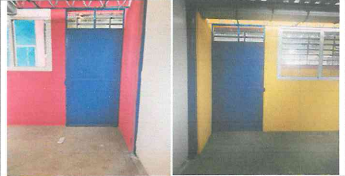
Foto 2: Sustitución de baranda de madera por puertas de metal.
