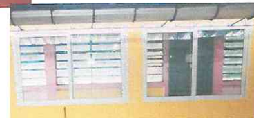
Foto 2: Instalación de ventana Pvc y vidrios de 1.80 metros x 1.50 metros.
