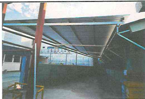
Foto 5: Sustitución de galera provisional de nylon, por galera de estructura metálica de 2.80 metros de alto, lamina troquelada calibre 26.
